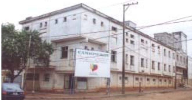
SANATORIO DE LA PROVINCIA DE MISIONES Adquirido con el apoyo económico de la Federación de Trabajadores Camioneros. Próximamente a reacondicionar.
